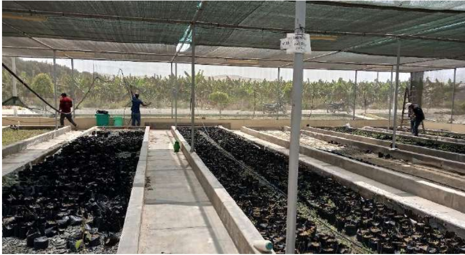
Fotografía N°03: Instalación de riego tecnificado en el vivero de biotecnología
