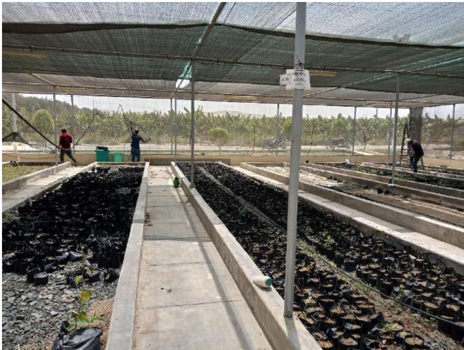
Fotografía N°03: Instalación de riego tecnificado en el vivero de biotecnología
