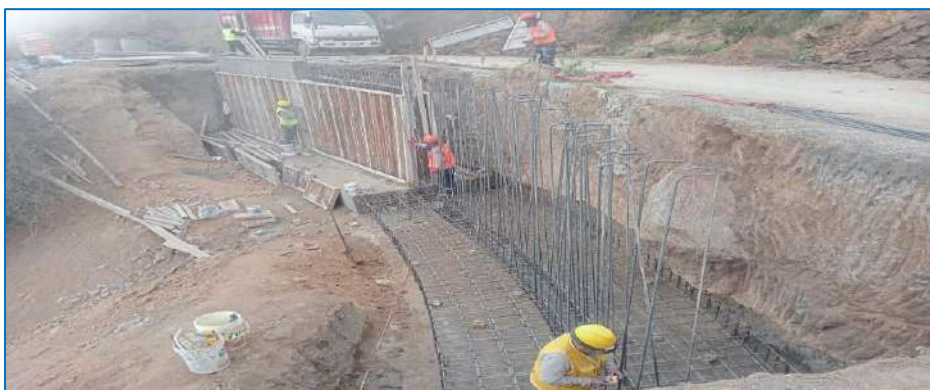
Figura N° 1: Muros de concreto
