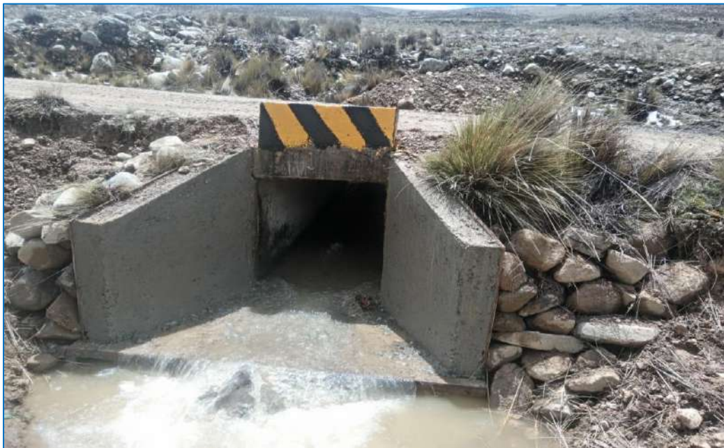
Figura N°20: Reparación de Alcantarillas
