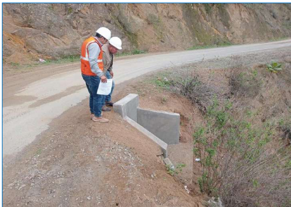
Figura N°4: Reparación de alcantarillas
