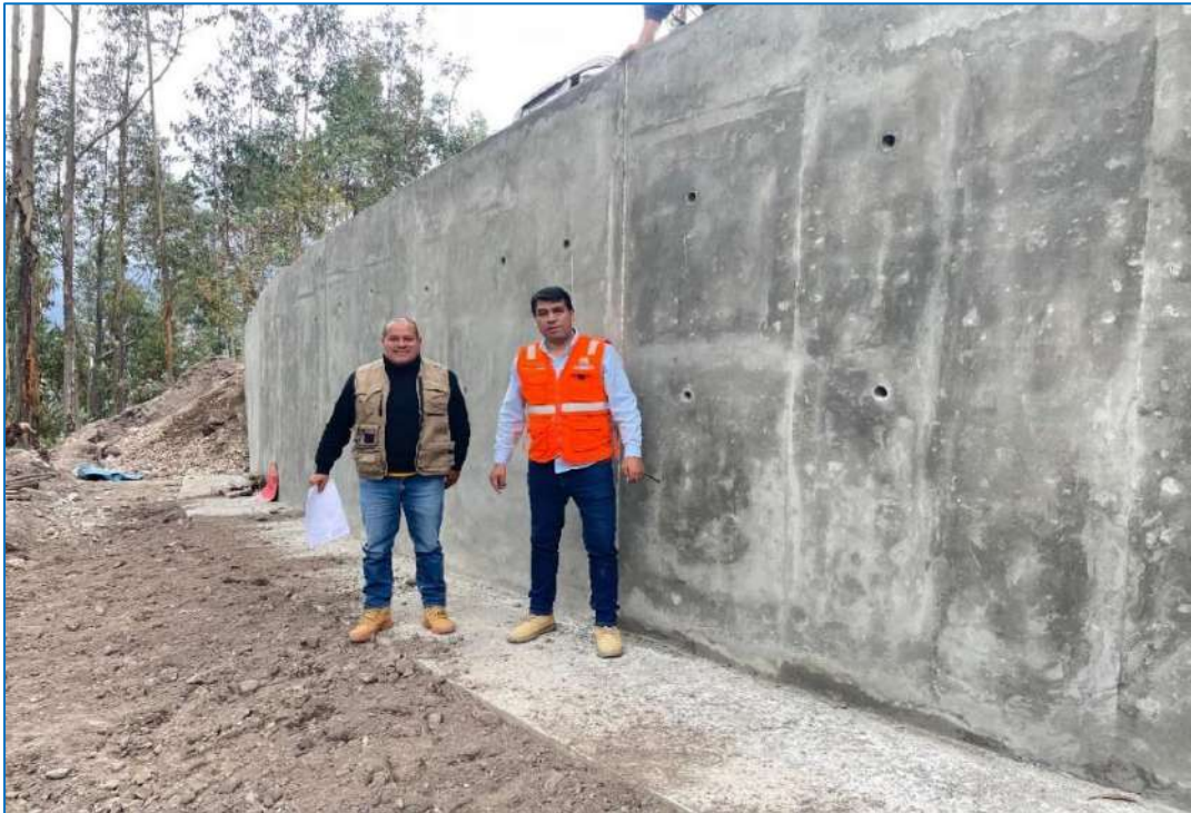
Figura N°14: Muros de Concreto
