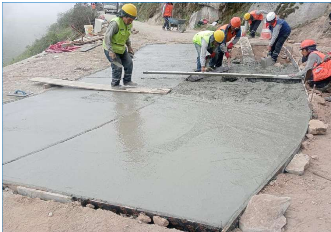
Figura N° 2: Reparación de Badenes
