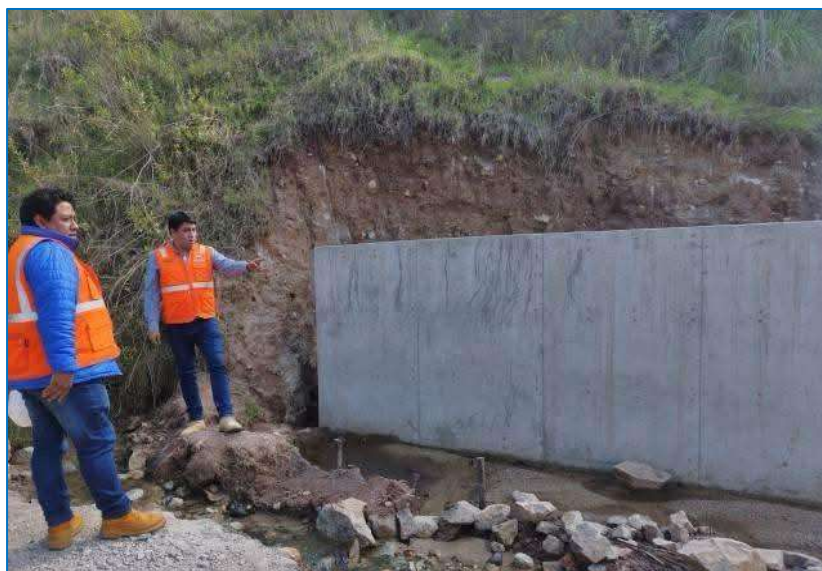
Figura N°5: Muros de concreto
