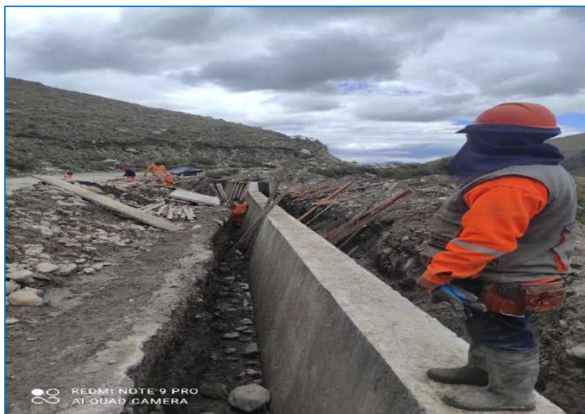
Figura N°12: Muros de Concreto
