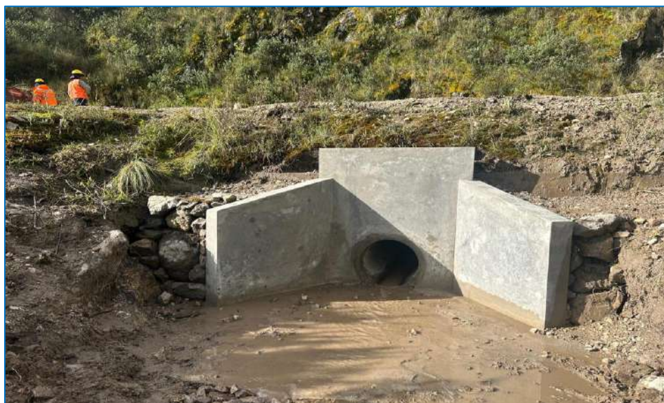
Figura N°17: Reparación de Alcantarillas
