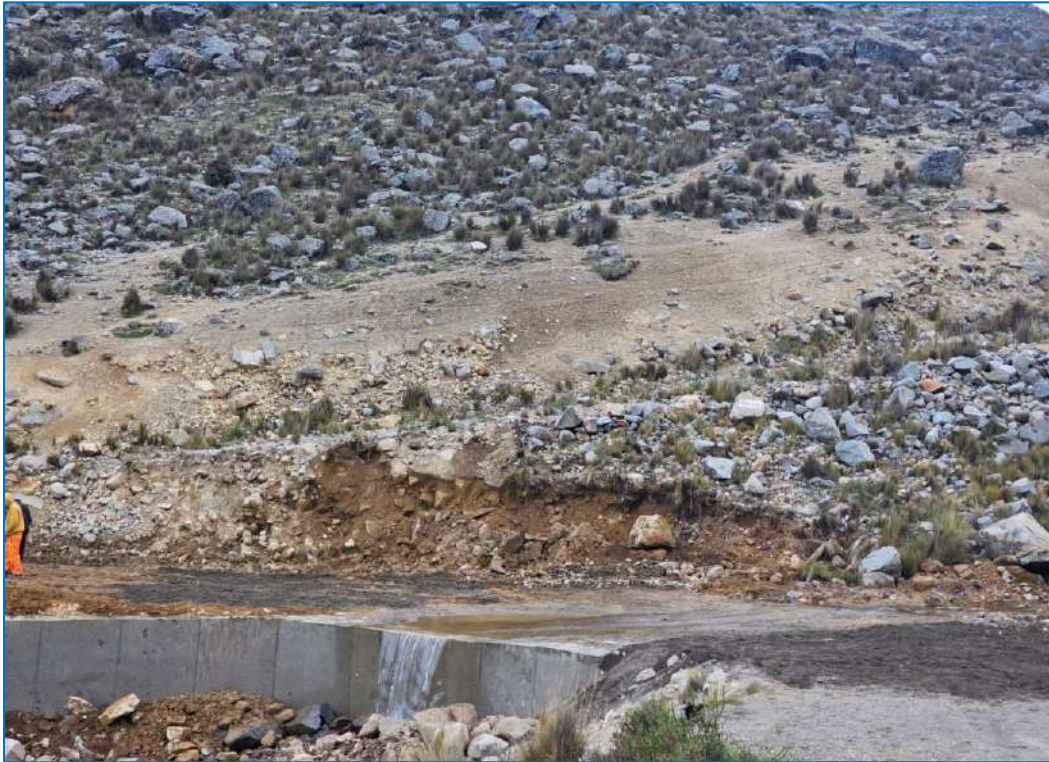
Figura N°19: Reparación de Badenes
