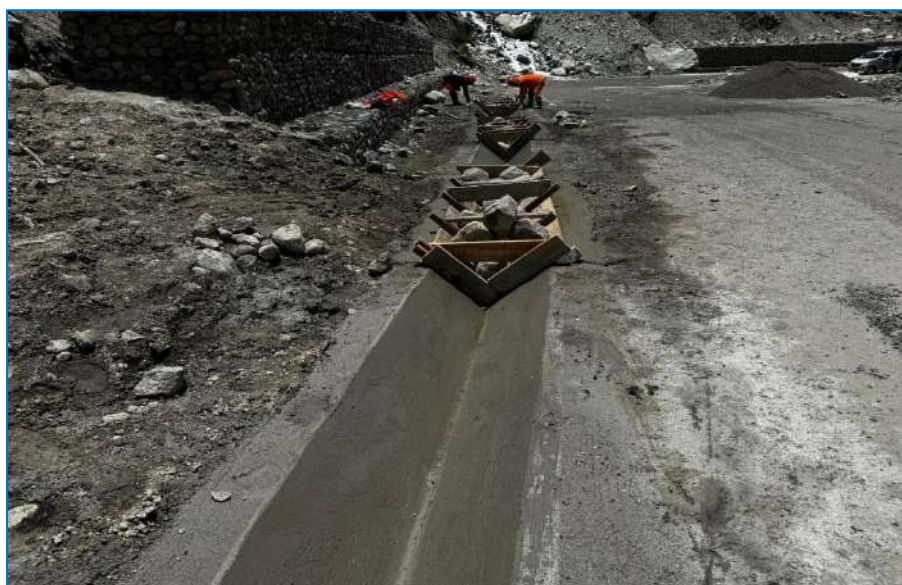
Figura N°13: Reparación de Cunetas
