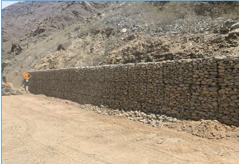
Figura N°8: Muro de Gaviones
