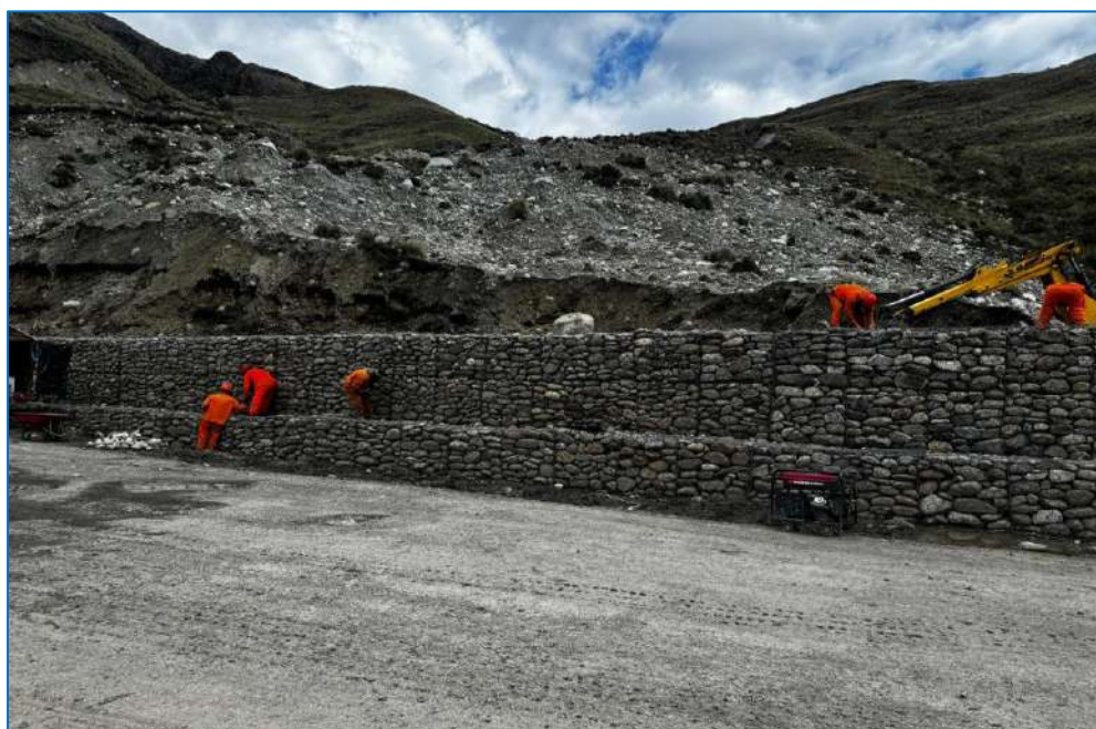
Figura N°11: Muros de Gaviones
