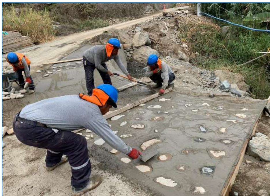
Figura N°10: Reparación de Badenes
