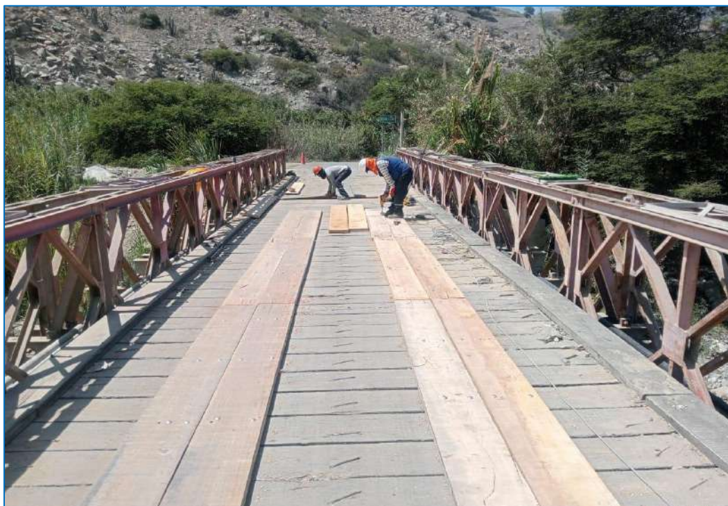
Figura N°3: Reparación de Puente de Madera
