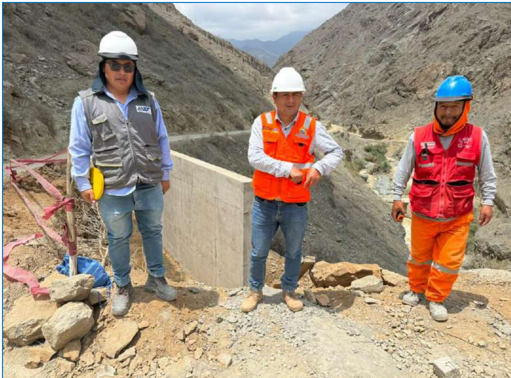
Figura N°9: Muros de Concreto
