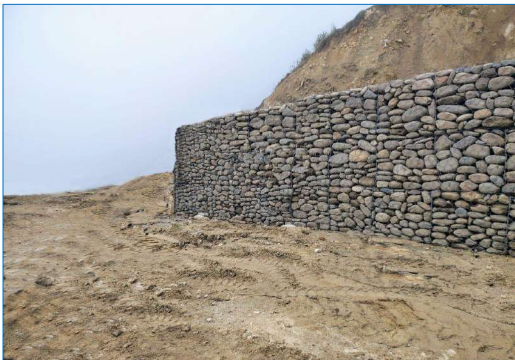
Figura N°18: Muros de Gaviones
