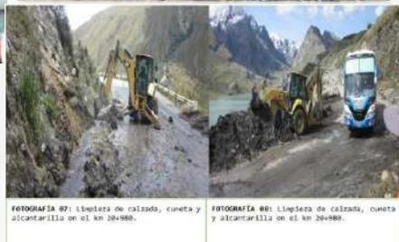
FOTOGRAFÍA 07: Limpieza de calzada, cuneta y alcantarilla en el km 20+880. FOTOGRAFÍA 08: Limpieza de calzada, cuneta y alcantarilla en el km 20+880.
